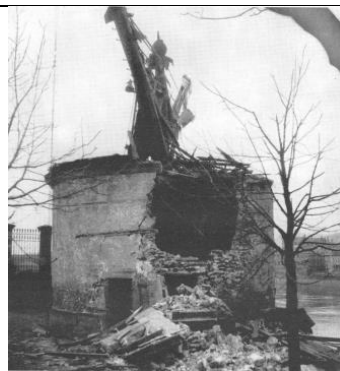
Krahnengebäude teilzerstört nach einem Bombenangriff
